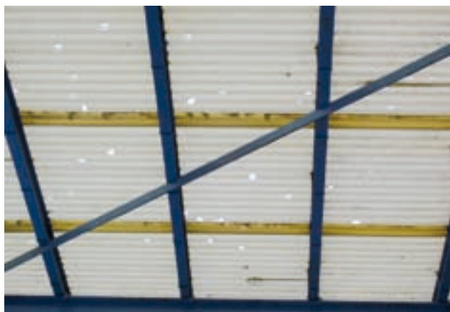
Figure 6.17: Panneaux de toiture en plastique, photo GVZ.
