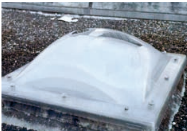
Figure 6.15: Coupole à deux couches, photo ECAB.
