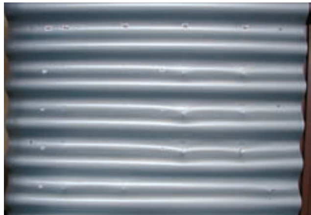
Figure 6.8: Tôle ondulée en aluminium, photo Empa.
